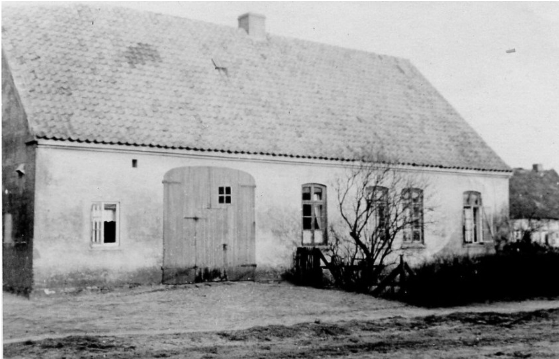
Das Bild zeigt das um 1900/01 von Heinrich Heins neu gebaute Haus Wächterstr. Nr. 5 oder Nr. 7, Ecke Lienertstr., Ansicht von der Lienertstraße. In der Karte der Landesbrandkasse (nicht datiert, vmtl. um 1880) ist an dieser Stelle das Haus Oyten 5 eingezeichnet. Zu dem Grundstück gehörten drei Häuslingshäuser mit den Nrn. 5a, 5b und 5c
