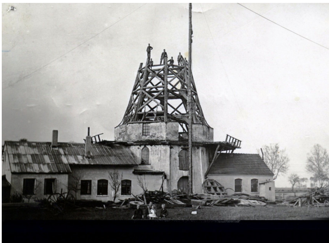
Bild 2: Um 1930 - die Oyter Mühle wird zurückgebaut.
