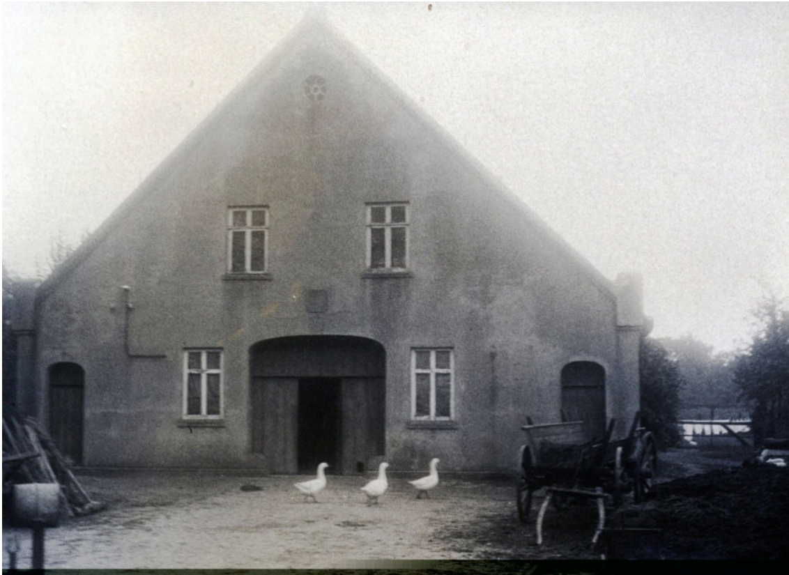
Das Foto zeigt das im Jahr 1864 neu errichtete Haus Oyten 16.
