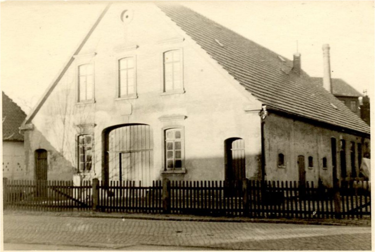
Das Haus wurde 1908 neu erbaut. Es steht auch noch im Jahr 2023 nahezu unverändert da. Der Schornstein im Hintergrund gehört zur alten Molkerei an der Lindenstraße (Oyten 144).
