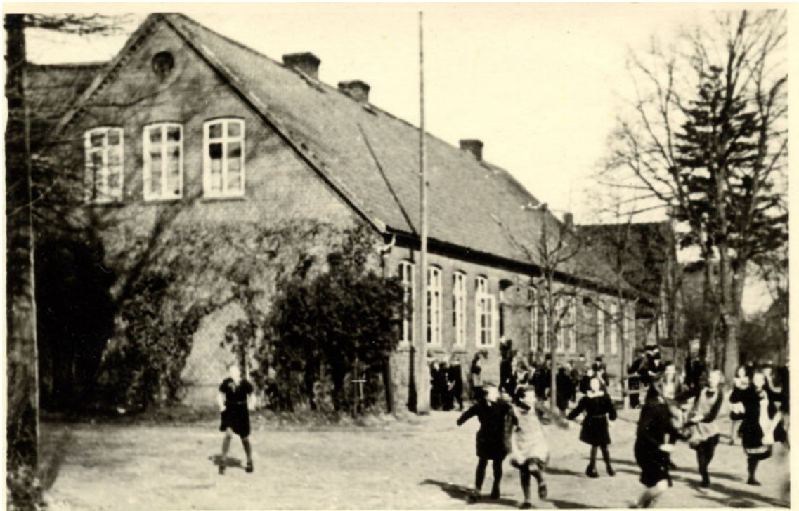
Bild 3 : Die dritte Schule an der Dorfstraße. Im OG lag die Lehrerwohnung.
