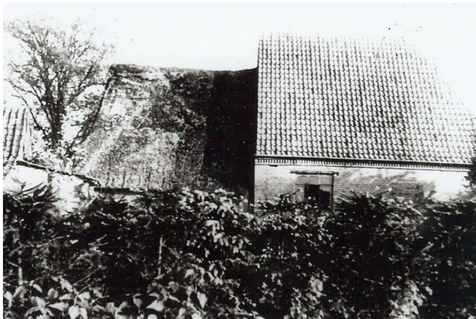
Links ein Teil des ersten Wohnhauses, rechts ein späterer Anbau.
